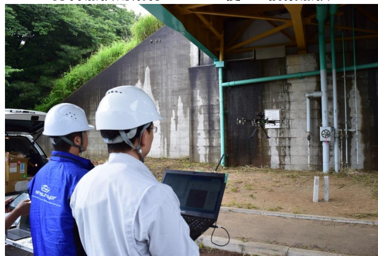
打音点検用飛行ロボットを使った橋梁点検
