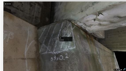
※1 3Dモデル損傷部タグ付け
